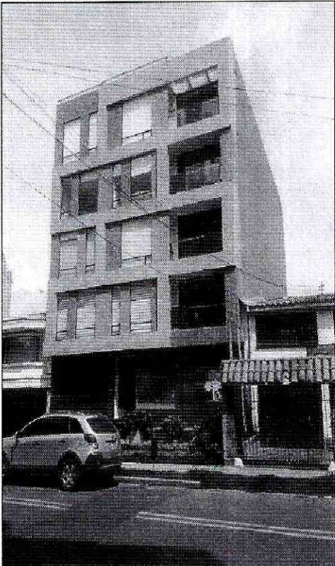
Fotografía 3. Edificio GAIA 104 ubicado en el predio de la Calle 104 B No. 58 – 31, en el Sector Catastral Puente Largo de la Localidad Suba. Se observa que cuenta con cinco (5) niveles.
