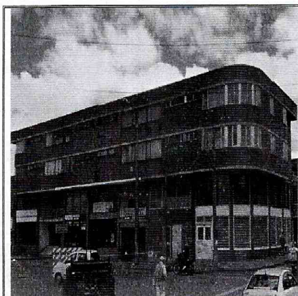
Foto No. 1. Vista general del predio de la Calle 6 No 24-08
