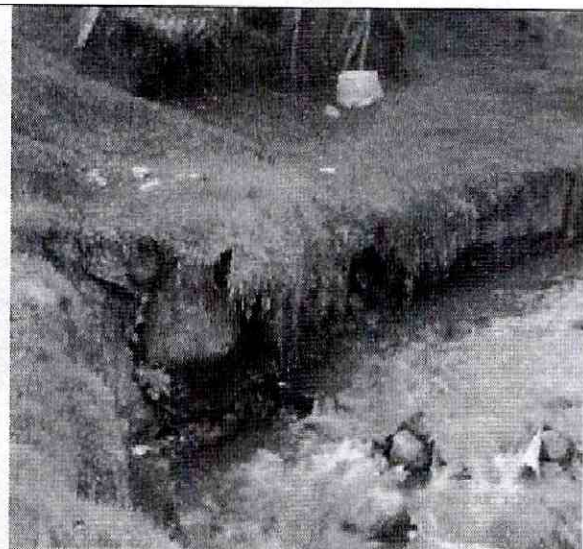
Fotografía 10: Pozo de inspección que se encuentra dispuesto en el cauce activo de la corriente.
