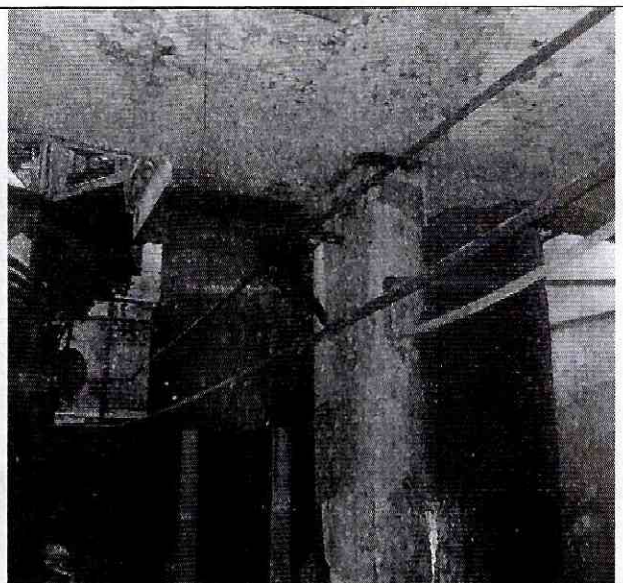
Fotografía 4. Vista de la columna y placa de contrapiso, área de reactores
