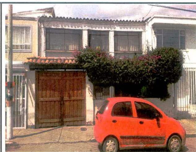
Fotografía 2. Vista de la fachada de la vivienda ubicada en el predio de la Calle 107 No. 8 A – 41, en el Sector Catastral Santa Ana Occidental de la Localidad Usaquén.
