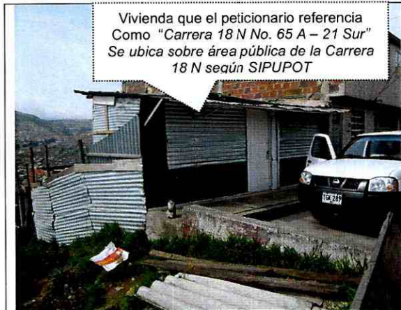
Fotografía 1. Vista de la edificación a la que hace referencia el peticionario.
