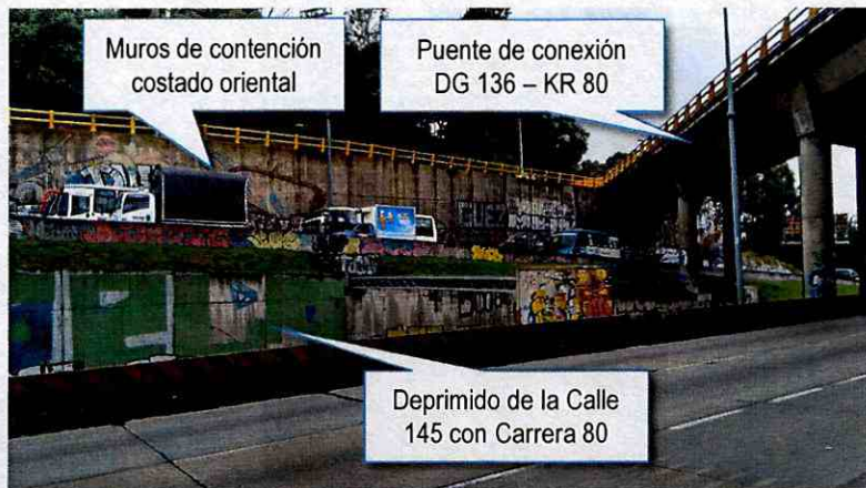
Fotografía 1. Vista general del sector de la Carrera 80 con Calle 145.
