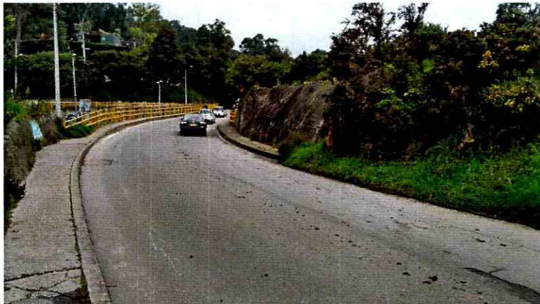
Fotografía 2. Vista del puente por la parte superior. No se presentan daños visibles en el tablero
