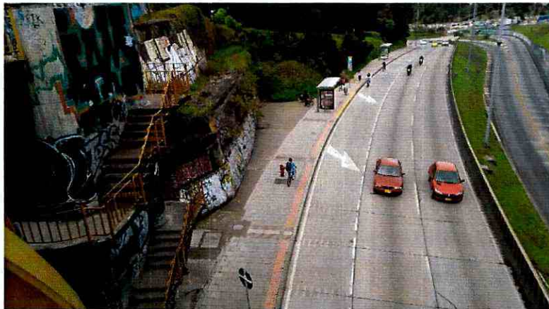
Fotografía 3. Escalera de acceso entre la Calle 145 y la Carrera 80 sin lesiones (Costado occidental del puente)
