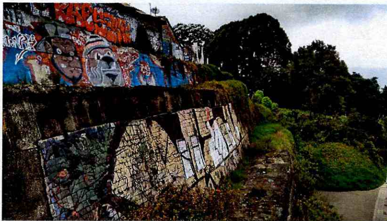
Fotografía 5. Muro de contención de la parte superior del talud en buenas condiciones (Costado Occidental del Puente)
