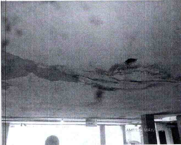
Fotografía 21. Presencia de humedad en la zona de estacionamiento del Conjunto Residencial La Esperanza I y II P.H. de la Calle 163B No. 45 - 32, en el Sector Catastral Britalia de la Localidad Suba.
