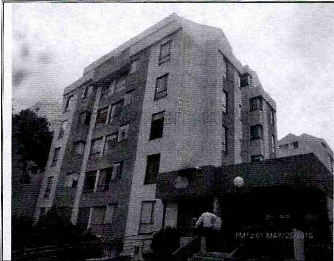
Fotografía 1. Vista del Conjunto Residencial La Esperanza I y II P.H. de la Calle 163B No. 45 - 32, en el Sector Catastral Britalia de la Localidad Suba.
