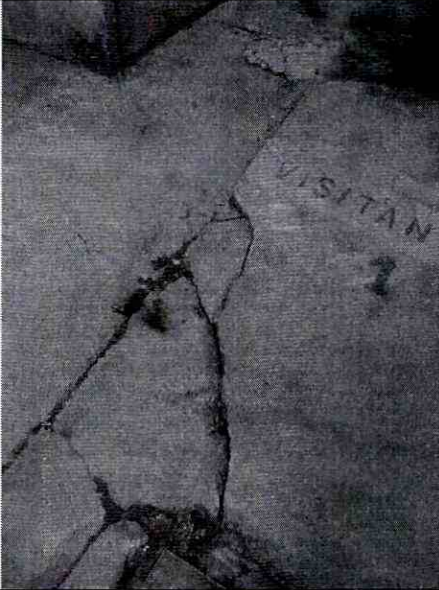
Fotografía 9. Presencia de grietas y hundimientos en losas de piso de la zona de estacionamiento del Conjunto Residencial La Esperanza I y II P.H. de la Calle 163B No. 45 - 32, en el Sector Catastral Britalia de la Localidad Suba.
