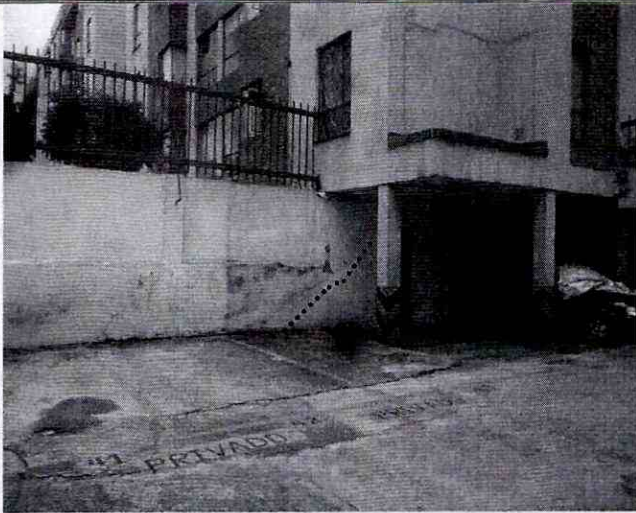
Fotografía 9. Presencia de grietas y hundimientos en losas de piso de la zona de estacionamiento del Conjunto Residencial La Esperanza I y II P.H. de la Calle 163B No. 45 - 32, en el Sector Catastral Britalia de la Localidad Suba.
