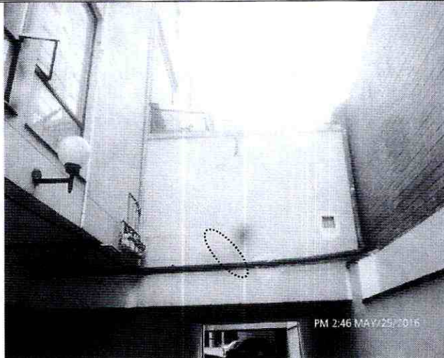
Fotografía 4. Presencia de fisuras en muros de cerramiento en la zona de estacionamiento del Conjunto Residencial Agrupación de Viviendas Escandinavia Norte P.H. de la Calle 147 No. 12 - 87, en el Sector Catastral Caobos Salazar de la Localidad Usaquén.
