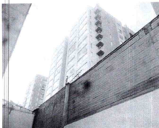
Fotografía 11. Vista de la edificación que se ubica al costado sur del Conjunto Residencial Agrupación de Viviendas Escandinavia Norte P.H. de la Calle 147 No. 12 - 87, en el Sector Catastral Caobos Salazar de la Localidad Usaquén.
