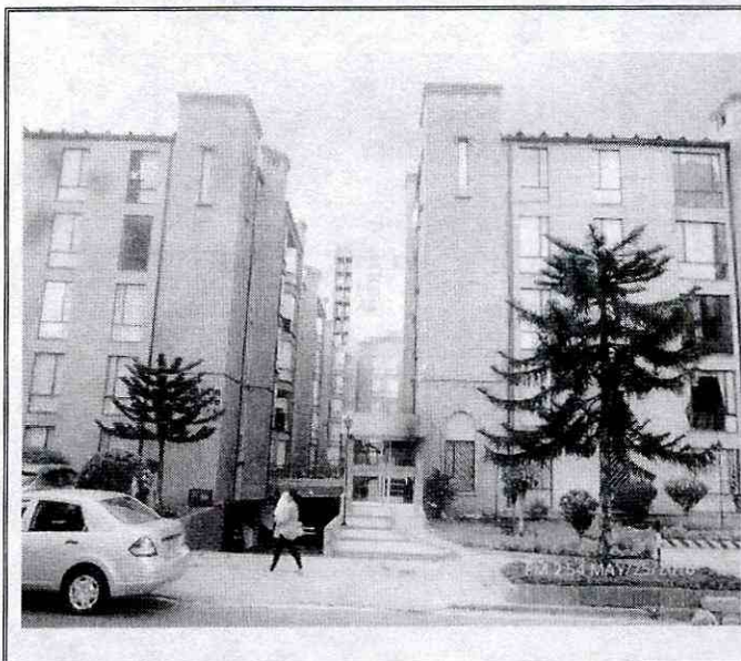
Fotografía 1. Vista del Conjunto Residencial Agrupación de Viviendas Escandinavia Norte P.H. de la Calle 147 No. 12 - 87, en el Sector Catastral Caobos Salazar de la Localidad Usaquén.
