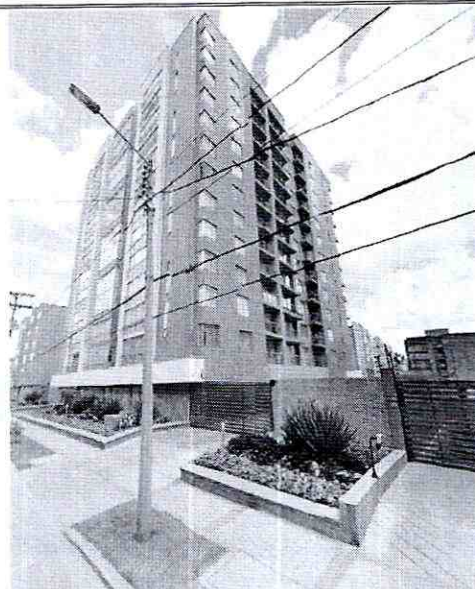
Fotografía 12. Vista de la edificación que se ubica al costado sur del Conjunto Residencial Agrupación de Viviendas Escandinavia Norte P.H. de la Calle 147 No. 12 - 87, en el Sector Catastral Caobos Salazar de la Localidad Usaquén.
