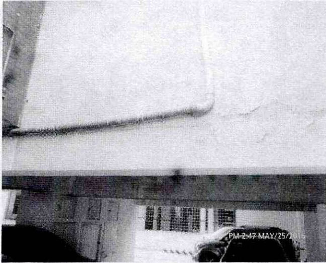
Fotografía 7. Presencia de humedad en muros de cerramiento en la zona de estacionamiento del Conjunto Residencial Agrupación de Viviendas Escandinavia Norte P.H. de la Calle 147 No. 12 - 87, en el Sector Catastral Caobos Salazar de la Localidad Usaquén.
