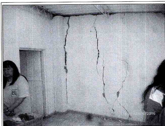
Foto 3 y 4. Vista de la habitación del costado oriental del predio evaluado, en donde se puede apreciar las fisuras que se presentan en los muros de cerramiento de este sector.
