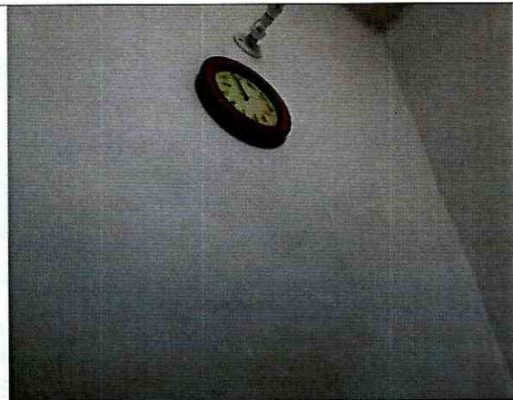
Fotografía 2. Vista de muro interior de la edificación emplazada en el predio de la Dg. 62 Sur No. 68 C - 21.
