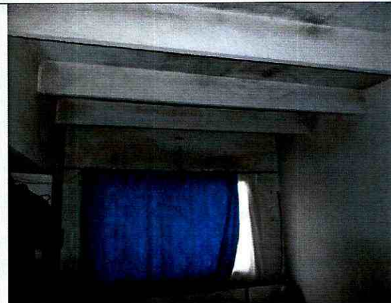
Fotografía 4. Vista de muro y placa de entepiso interior de la edificación emplazada en el predio de la Dg. 62 Sur No. 68 C - 21.
