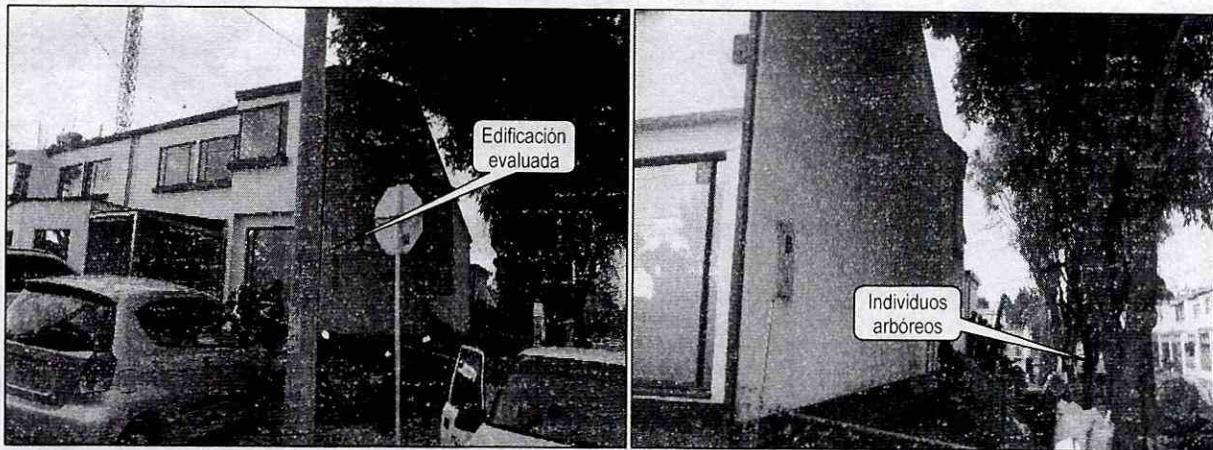
Fotografía 1 y 2. Fachada principal de la edificación de la Calle 128 B No. 57 C - 06, en el Sector Catastral Prado Veraniego Sur, de la Localidad de Suba, así como la proximidad de los individuos arbóreos
