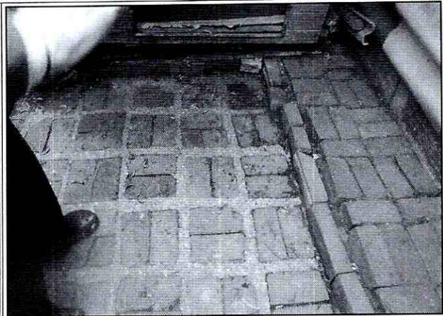
Foto 5 y 6. Vista de los hundimientos de los adoquines localizados en el acceso a la vivienda evaluada.
