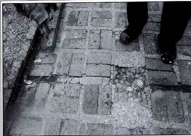
Foto 5 y 6. Vista de los hundimientos de los adoquines localizados en el acceso a la vivienda evaluada.
