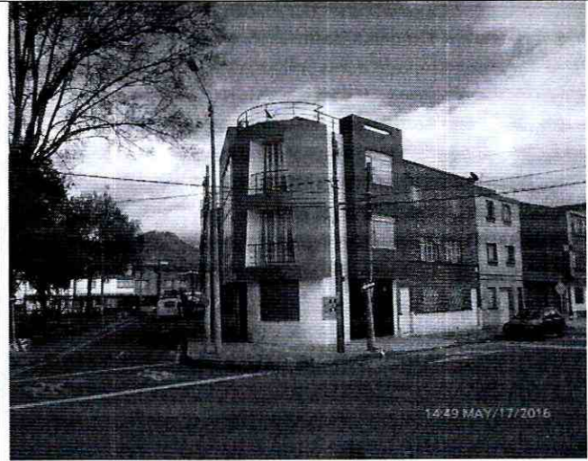
Fotografía 12. Vista de las vías adyacentes a la edificación de la Carrera 28B No. 74 - 96, en el Sector Catastral La Aurora de la Localidad Barrios Unidos.
