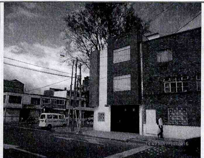
Fotografía 2. Vista por la Carrera 28B de la edificación ubicada en la Carrera 28B No. 74 - 96, en el Sector Catastral La Aurora de la Localidad Barrios Unidos.
