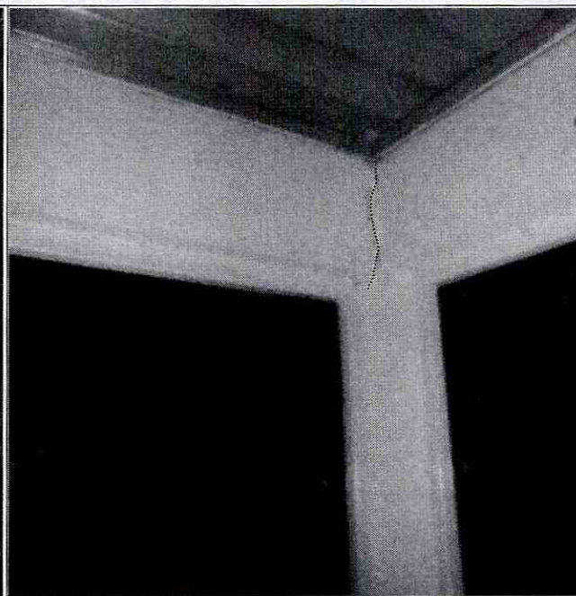
Fotografías 3 y 4. Fisuras de tendencia longitudinal de aberturas cercanas hasta de 2mm y longitudes entre 0.3m y 0.2m, en elementos no estructurales como dinteles, bordes de vanos y andenes.
