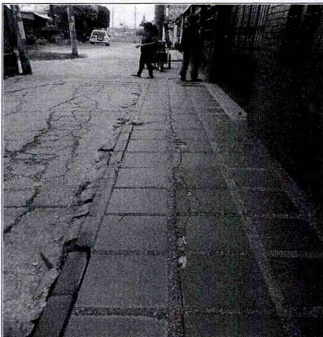
Fotografías 3 y 4. Fisuras de tendencia longitudinal de aberturas cercanas hasta de 2mm y longitudes entre 0.3m y 0.2m, en elementos no estructurales como dinteles, bordes de vanos y andenes.
