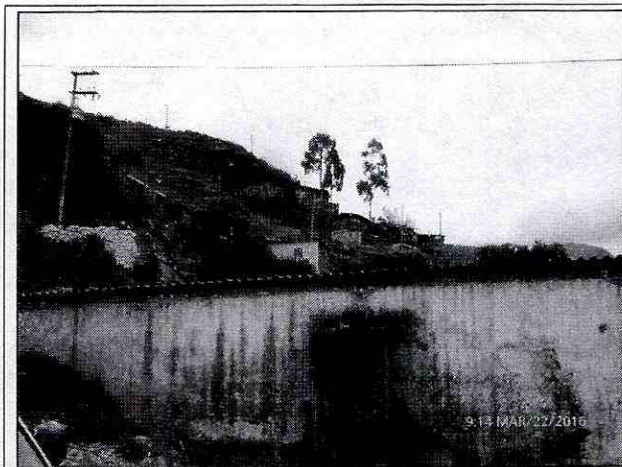
Foto 1. Vista del sector donde se localiza el predio de la Diagonal 2A Sur No. 6A-44 Este, Barrio El Dorado de la Localidad de Santa Fe.
