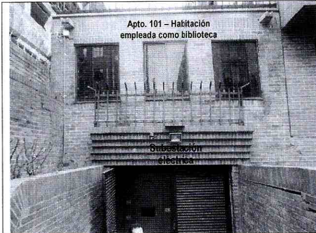
Fotografía 13: Subestación eléctrica – La subestación eléctrica se localiza debajo de la habitación empleada por el Apartamento 101 y que presenta las mayores afectaciones del predio.
