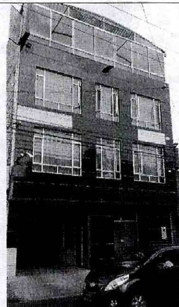
Foto 2. Vista de la vivienda emplazada en el predio de la Calle 17A No 97-46/48, Sector Catastral Centro de Fontibón de la localidad de Localidad de Fontibón.
