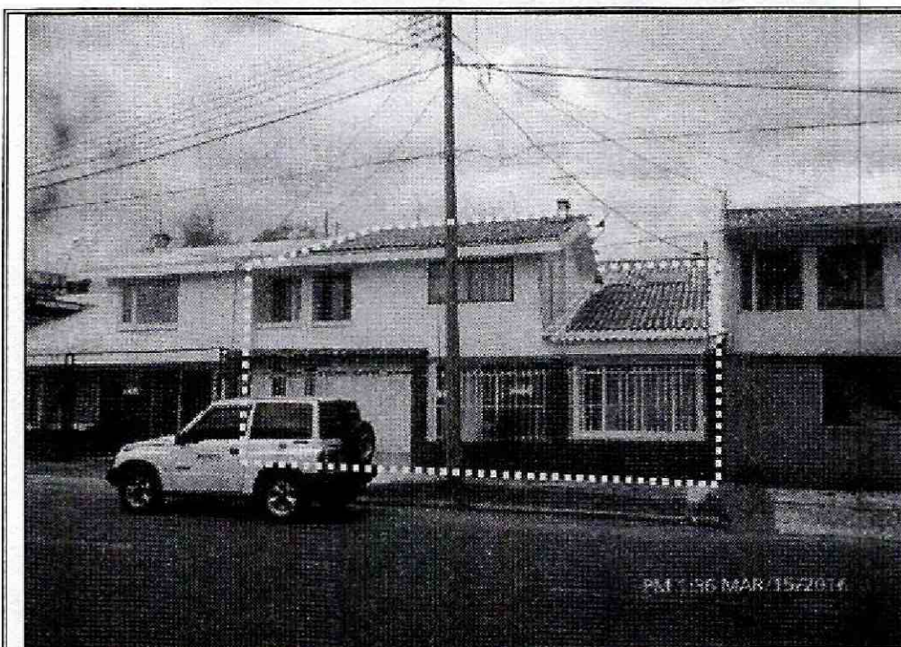
Fotografía 1. Vista de la vivienda ubicada en el predio de la Calle 84 No. 21 – 26, en el Sector Catastral Polo Club de la Localidad Barrios Unidos. Se observa que presenta dos (2) niveles.
