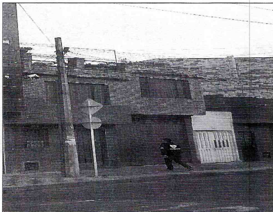
Foto 1. Vista de la vivienda emplazada en el predio de la Calle 17 No 97-44, Sector Catastral Centro de Fontibón de la localidad de Localidad de Fontibón.
