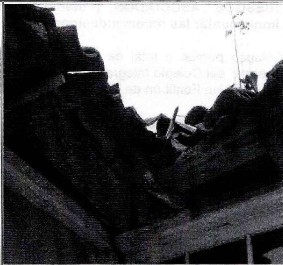
Foto No. 10. Deterioro elementos de madera que componen la estructura de cubierta de "La Casona"
