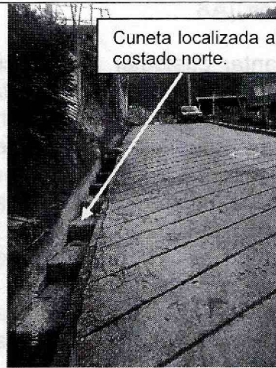
Fotografía 6 Se observa La vía de la Diagonal 40, corresponde a una vía en pavimento rígido y la cuneta localizada al costado norte.
