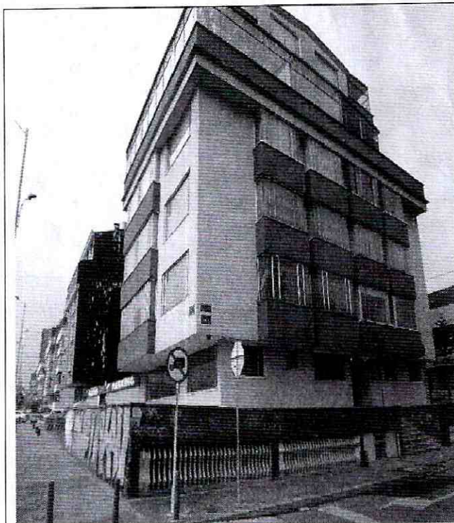
FOTOGRAFIA No 1. Vista de la edificación localizada en el predio de la Calle 60 No. 30 – 11, en el Barrio Catastral Campin Occidental de la Localidad Teusaquillo. Se observa que cuenta con seis (6) niveles y un (1) sótano de estacionamiento.
