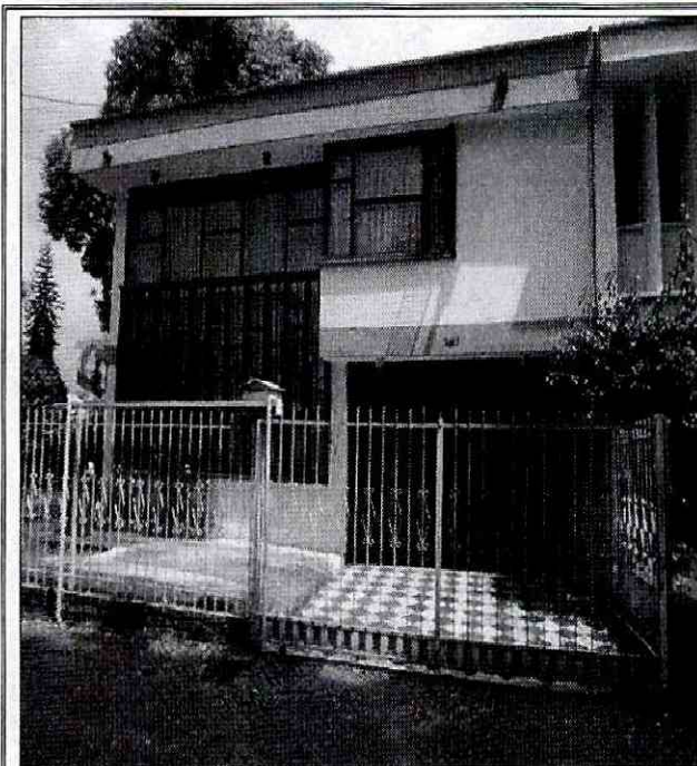
Fotografía 13. Vista de la fachada de la vivienda ubicada en el predio de la Calle 103 B No. 47 A - 03, en el Barrio Catastral Estoril de la Localidad de Suba. Se observa que presenta dos (2) niveles.
