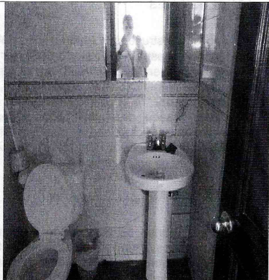
Fotografía 6. Fisura tendencia escalonada en muro divisorio
