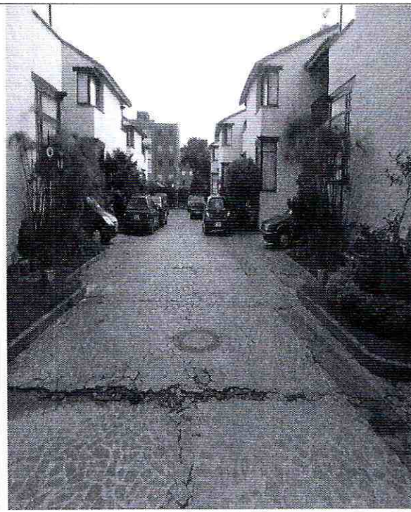
FOTOGRAFIA No 2. Vía de acceso al Conjunto Residencial Aragón se encuentra ubicado en el predio de la Calle 142 No. 9 – 71 en el Sector Catastral Cedritos de la Localidad de Usaquén.
