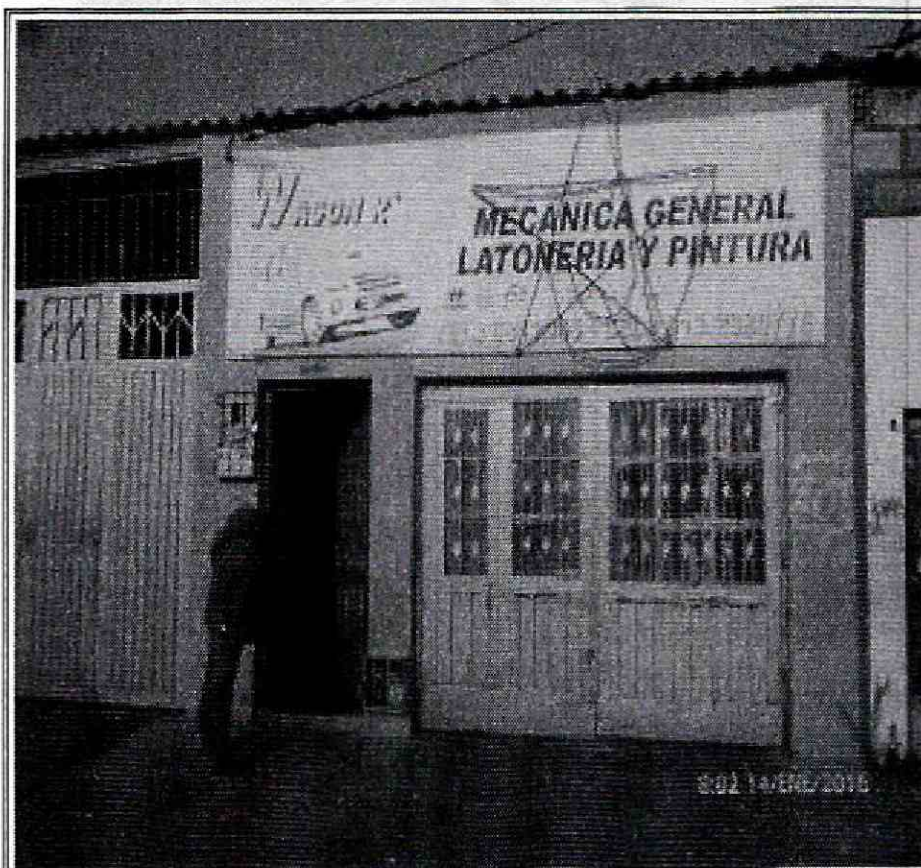
Foto No. 1. Vista frontal del predio de la Carrera 98 B No. 132 C - 13 Urbanización La Chucua
