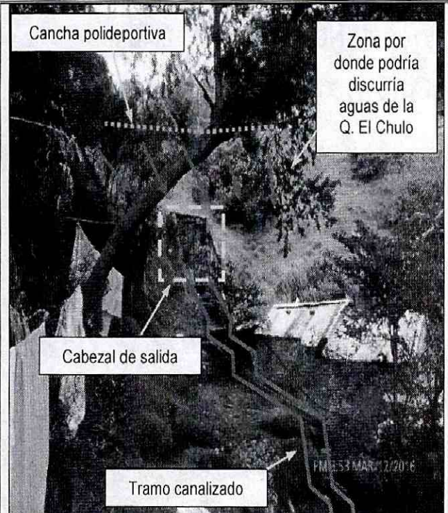
Fotografía 4. Vista de la parte baja de la ladera en donde se ubica el tramo canalizado de la quebrada El Chulo; zona donde se emplazan viviendas dentro del cauce natural de la quebrada, por lo que es factible la ocurrencia de encharcamientos ante nuevos desbordamientos.
