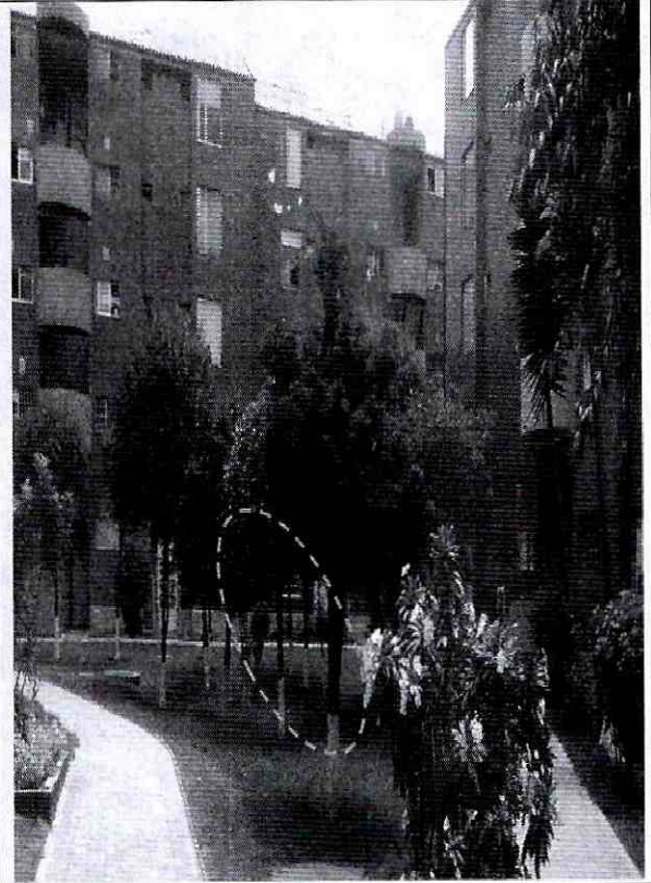
FOTOGRAFIA No 4. Detalle zona Verde Interior del Conjunto Residencial San Antonio Norte.
