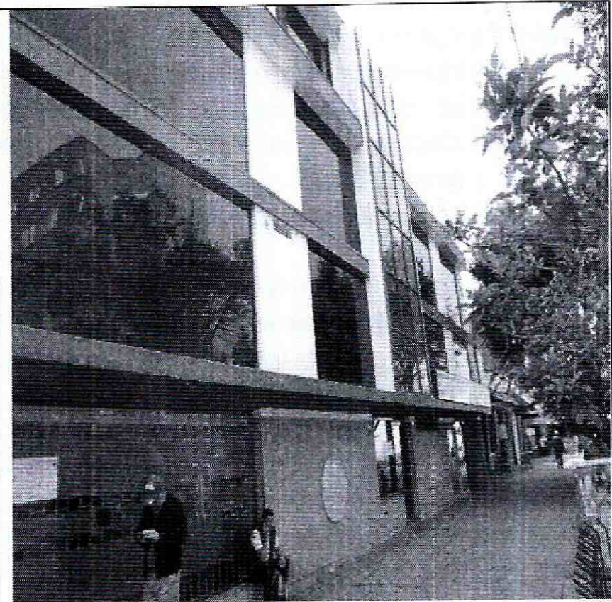
Fotografía 2. Vista frontal del predio por la Carrera 37 Edificio Coaacueducto.
