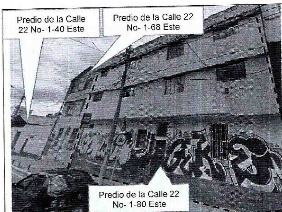
Fotografía 5. Vista de la fachada del predio de la Calle 22 No. 1-80 Este.
