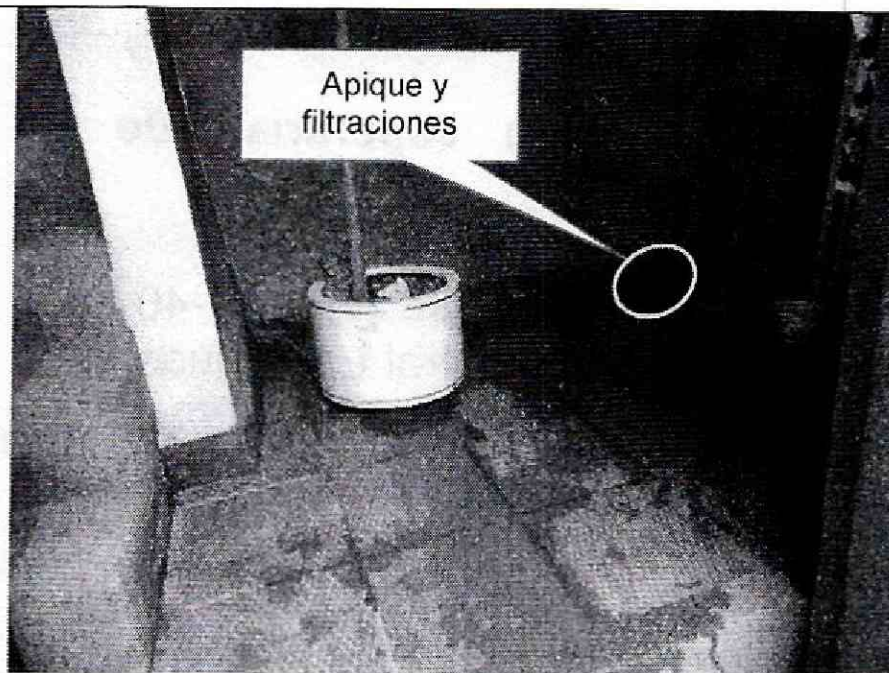
Fotografía 3. Filtración en la zona central de la construcción emplazada en los predios de la Calle 22 No. 1-40 Este y Lote 26 de la Calle 22 No. 1-98 Este.
