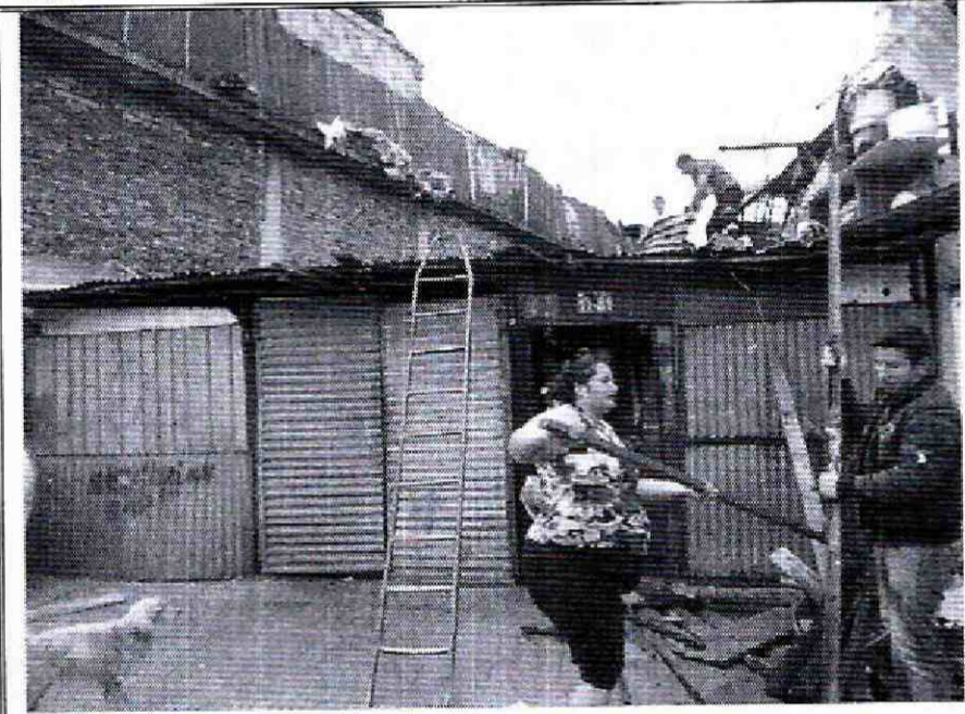
Foto No. 6. Aspecto de la vivienda de la Carrera 57 No. 17-81, en el Sector Catastral de Puente Aranda, de la Localidad de Puente Aranda.
