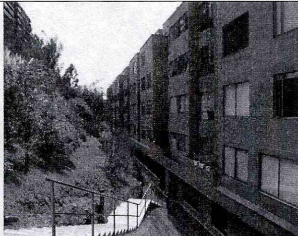
Foto No 2 Fachada posterior del predio evaluado
