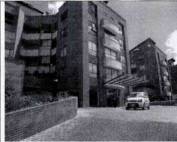
Foto No 1 Fachada principal del predio evaluado
