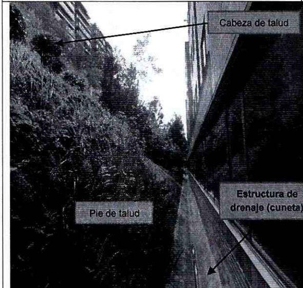
Foto No 7 Vista pie del talud
