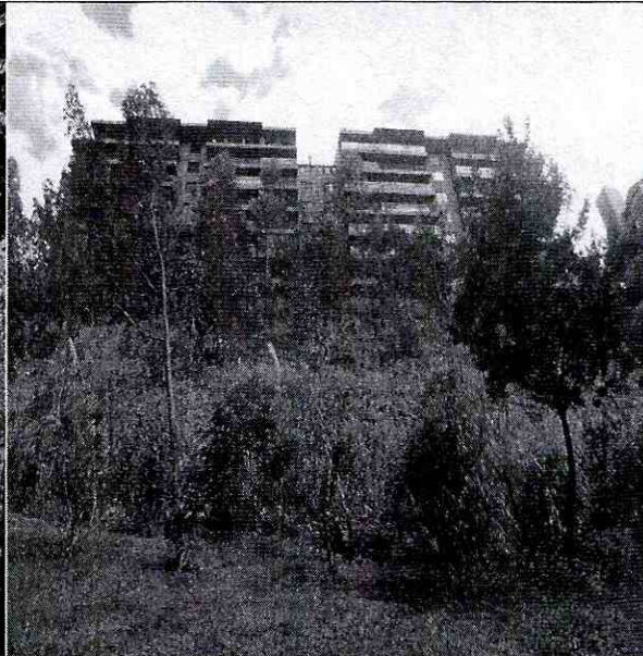
Foto No 4 Vista frontal del Talud
