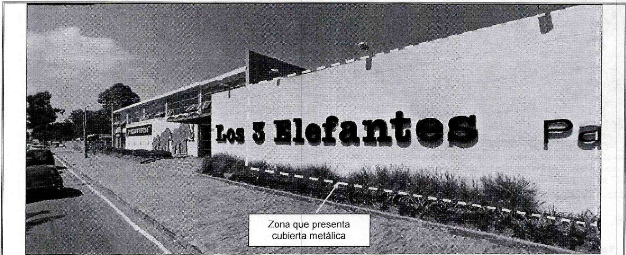
Fotografía 1. Fachada del almacén Los Tres Elefantes, en el predio de la Carrera 53 No. 102 A – 77 en el Sector Catastral Pasadena de la Localidad Suba. Se identifica la zona que presenta cubierta en tejas de fibrocemento, soportadas por una estructura metálica.
