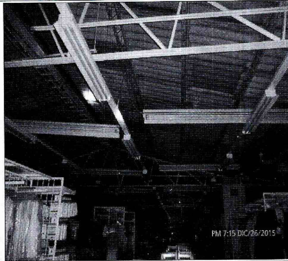
Fotografía 5. Tipología de la estructura de soporte de la cubierta del almacén los Tres Elefantes en el predio de la Carrera 53 No. 102 A – 77 en el Sector Catastral Pasadena de la Localidad Suba.
