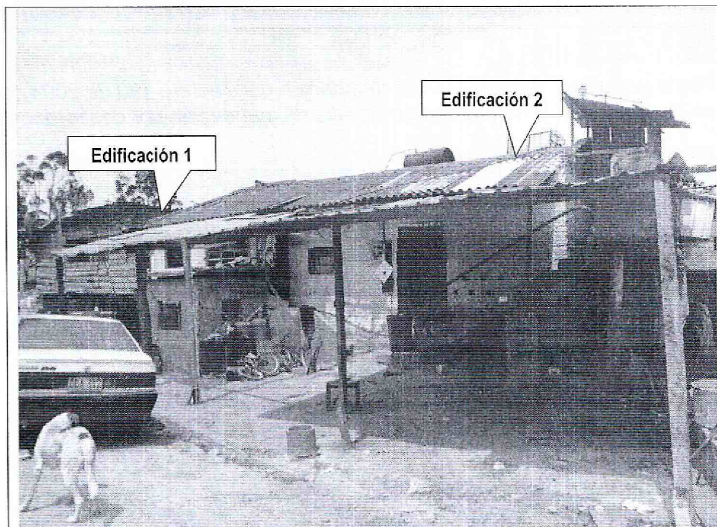
Fotografía 1. Vista frontal de las edificaciones 1 y 2 emplazadas en el predio denominado "Las Marraneras"
