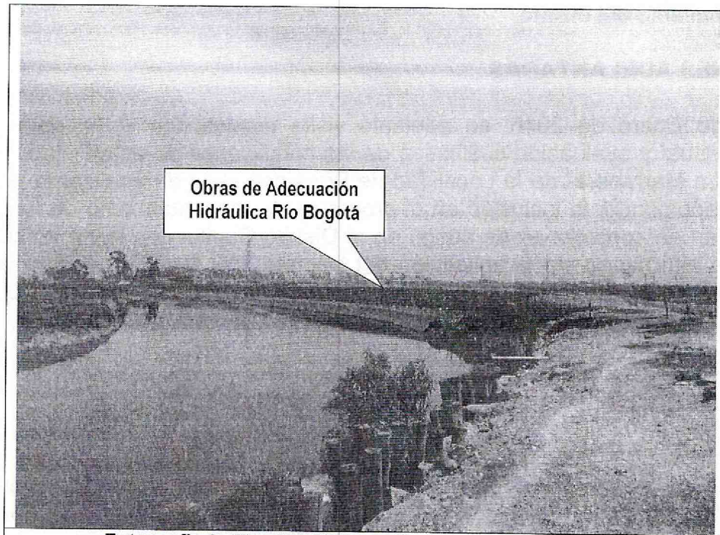
Fotografía 9. Obras de Adecuación Hidráulica Río Bogotá
