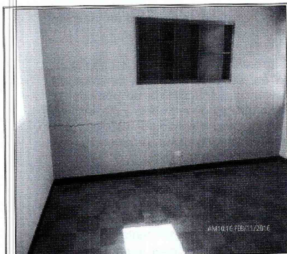
Fotografía 3. Fisuras y grietas de tendencia horizontal y diagonal en muros de cerramiento y divisorios del costado sur de la edificación del predio de la Diagonal 108 A No. 8 – 65 en el Sector Catastral santa Ana Occidental de la Localidad Usaquén.
