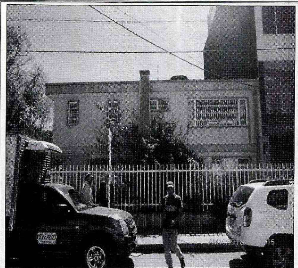
Fotografía 2. Vista del predio ubicado en la Diagonal 108 A No. 8 – 65 en el Sector Catastral Santa Ana Occidental de la Localidad Usaquén. Se observa que presenta dos (2) niveles.
