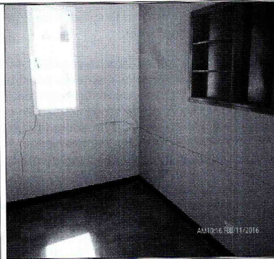
Fotografía 4. Fotografía 3. Fisuras y grietas de tendencia horizontal y diagonal en muros de cerramiento y divisorios del costado sur de la edificación del predio de la Diagonal 108 A No. 8 – 65 en el Sector Catastral santa Ana Occidental de la Localidad Usaquén.
