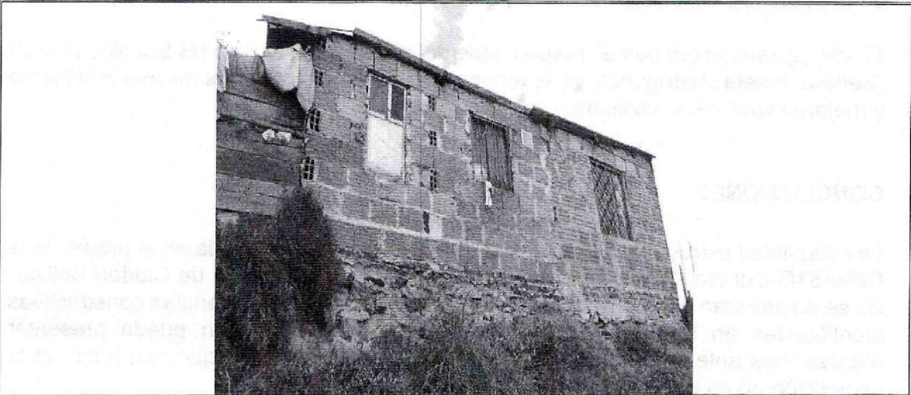
Foto No. 4. Talud de relleno y muro en piedra pegada, sobre el costado oriental de la vivienda evaluada.
