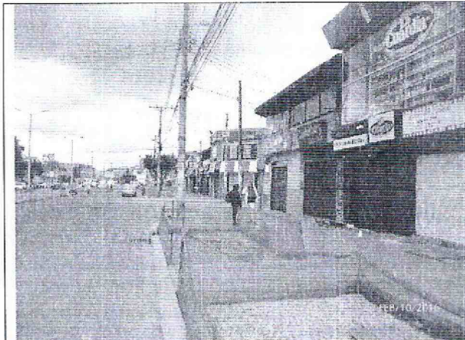
Fotografía 1. Vista de las actividades de construcción realizadas en el sector
