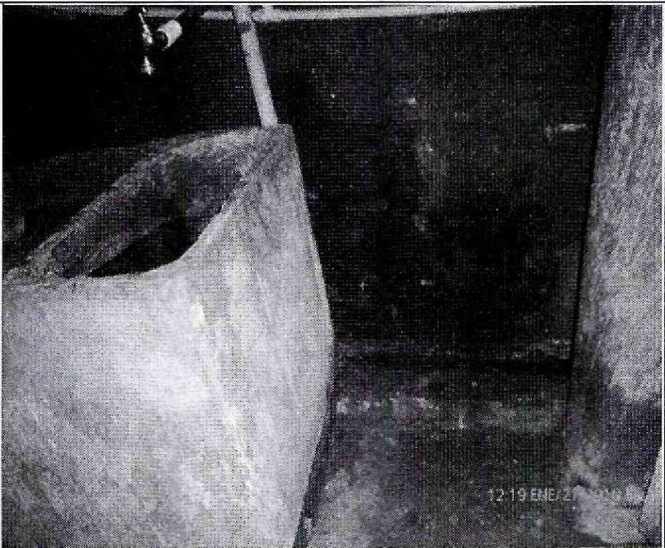
Fotografía 5 y 6. Se identifica que el manejo de las aguas servidas no es el adecuado ya discurren sin ningún tipo de conducto generando las humedades identificadas en dicho costado del predio.
