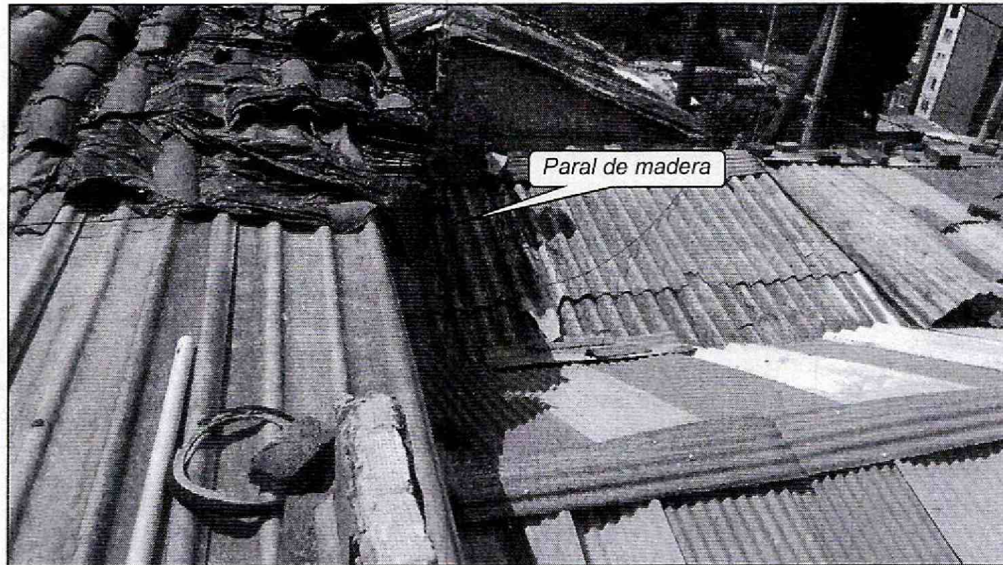
Fotografía 11. Vista del paral instalado para ayudar al sostenimiento de la cubierta de la vivienda de la Calle 4 Sur No. 5-48, en el Barrio Las Brisas, de la Localidad de San Cristóbal
