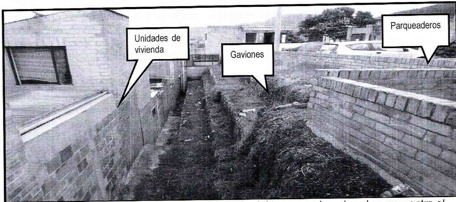
Fotografía 2. Infraestructura para la estabilización del terreno sobre el cual se encuentra el parqueadero del Conjunto Residencial Mirador de Santa Fé, en el Sector Las Cruces, de la Localidad de Santa Fé.
