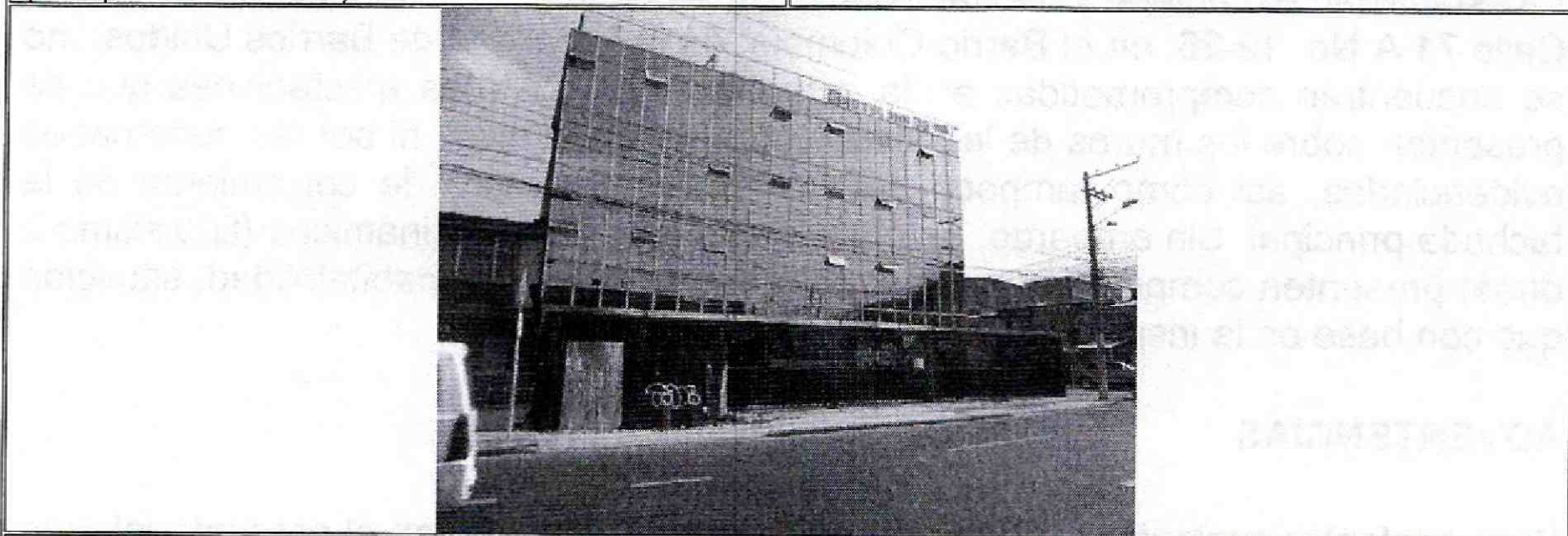
Foto No. 7. . Aspecto de la edificación emplazada en la Cra. 19 No. 71 A-03, en el Barrio Colombia, de la Localidad de Barrios Unidos, la cual está habilitada como hotel.
