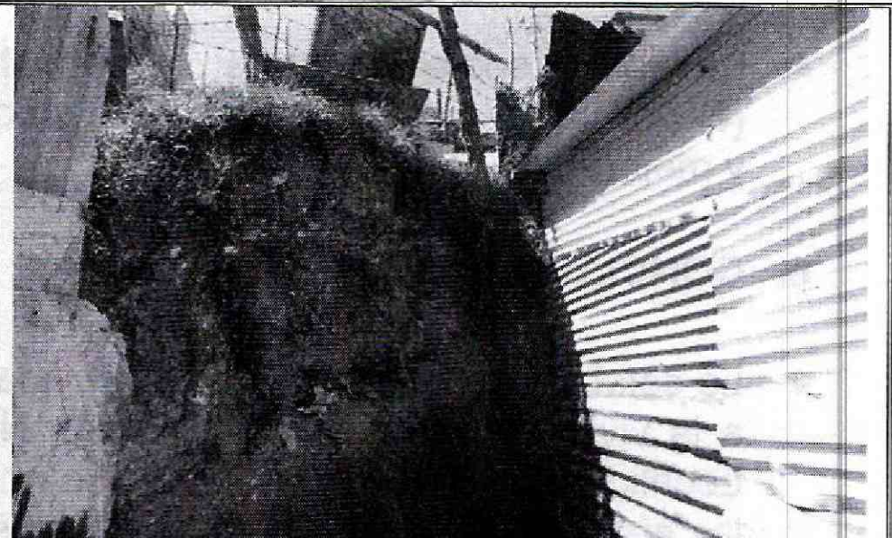
Foto No. 4. Talud de corte sobre el costado occidental, de la vivienda emplazada en la Calle 70 M Sur No. 19F-30.
