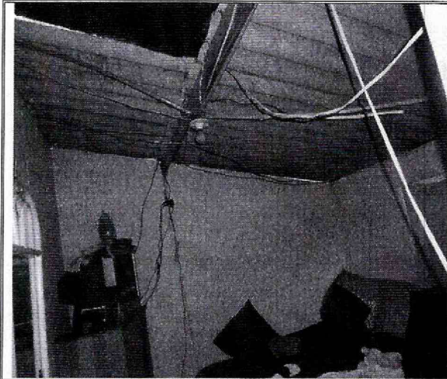
Foto No. 3. Vista interior de una alcoba en el predio de la Calle 71G Bis Sur No. 27 L – 81
