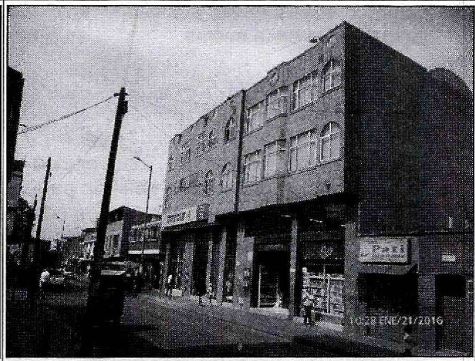
Foto 8. Vista de la edificación emplazada en el predio de la Carrera 100 No. 16H-63/71/77 en el Barrio El Carmen de la Localidad de Fontibón, donde funciona Cooratiendas.
