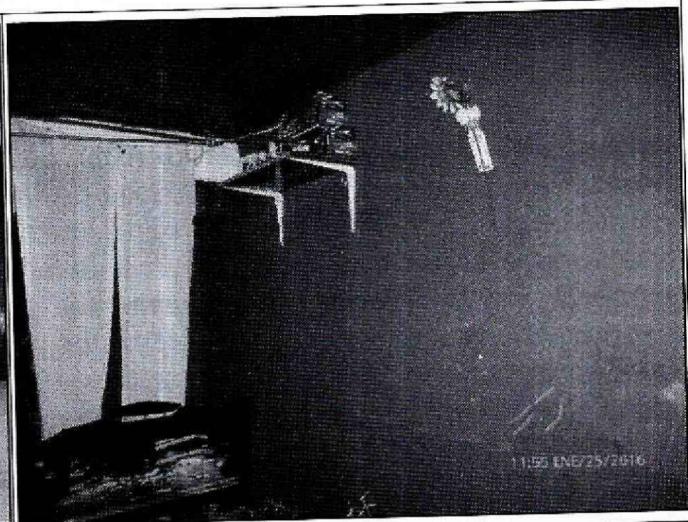
Foto 4. Vista al interior de la vivienda en la que no se evidencian daños adicionales que comprometan la estabilidad estructural y habitabilidad de la misma.
