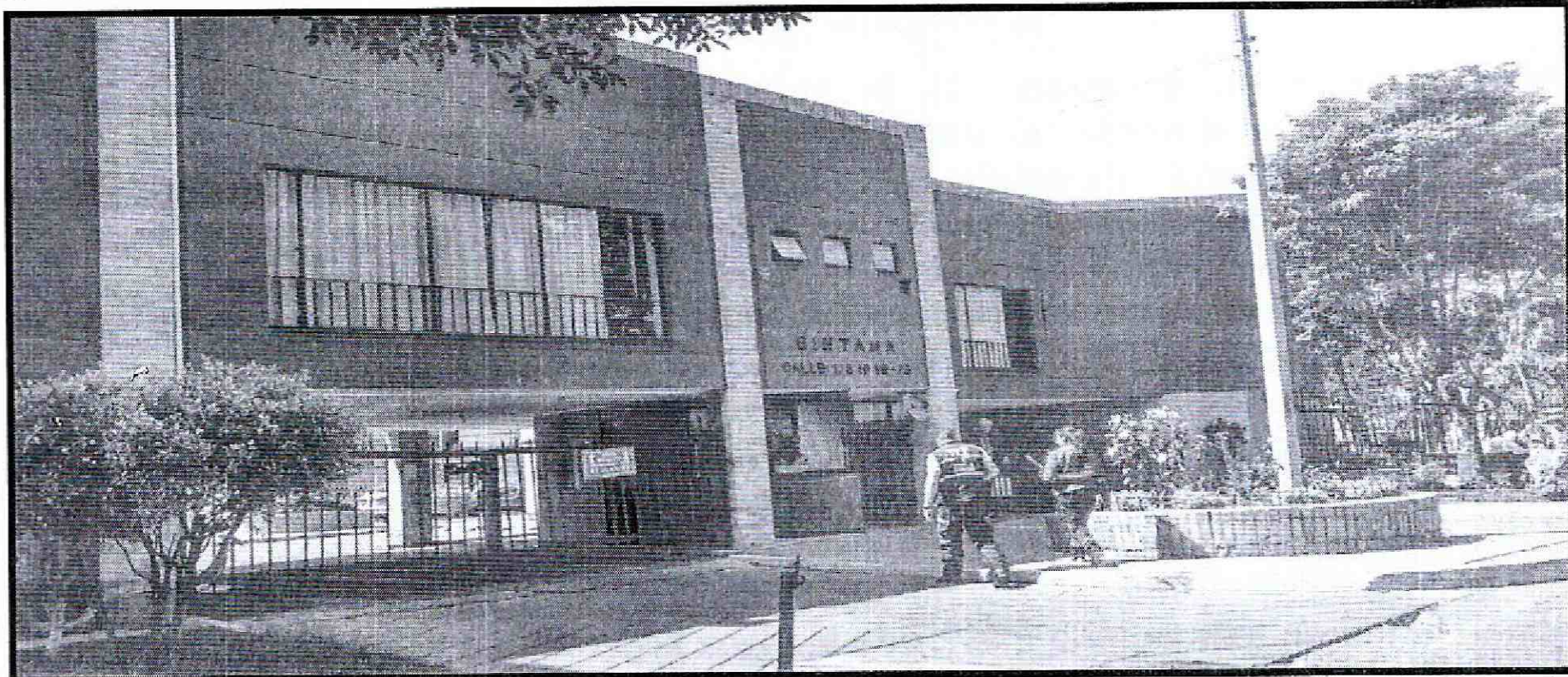
Fotografía 1. Vistas general al exterior del conjunto residencial de la Calle 173 No 19-75 en el Sector La Uribe, de la Localidad de Usaquén
