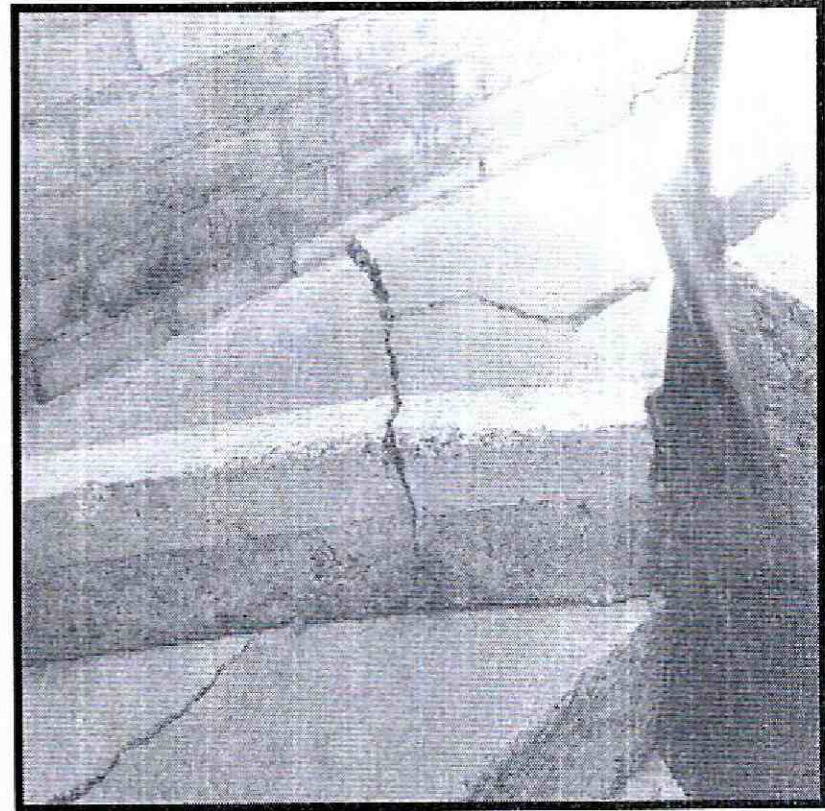
Fotografías 7 y8. Fracturas en la placa que sostiene los escalones y en los escalones de la escalera, que permite el acceso peatonal al sótano en el conjunto residencial del predio de la Calle 173 No 19-75 en el Sector La Uribe, de la Localidad de Usaquén.
