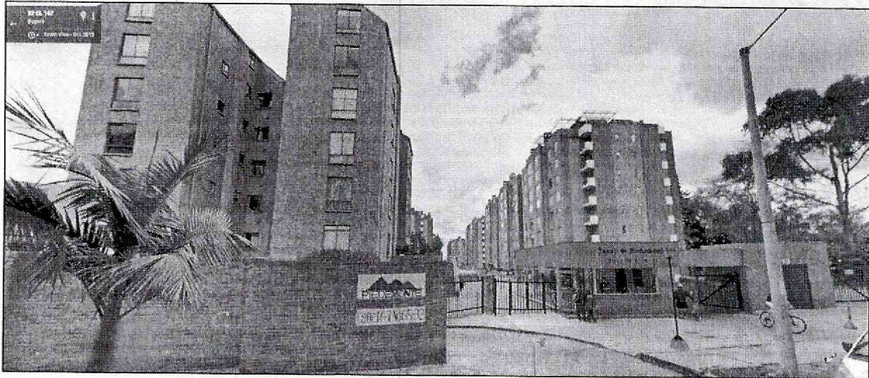
Fotografía 1. Fachada de la Agrupación de Vivienda Takalí de Piedemonte P.H. emplazada en el predio de la Calle 167 No. 74-32, en el Barrio Casablanca de la Localidad de Suba
