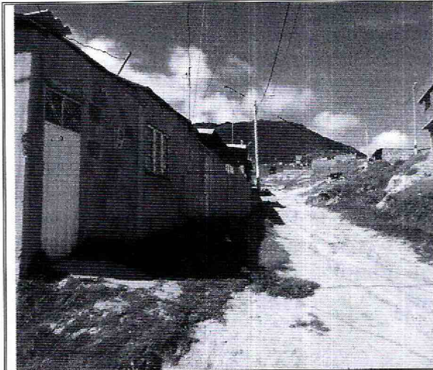
Foto No. 1. Vía de acceso a la vivienda emplazada en Calle 93 Sur No. 18B-06, en el Barrio Barranquitos-Mochuelo Bajo de la Localidad de Ciudad Bolívar
