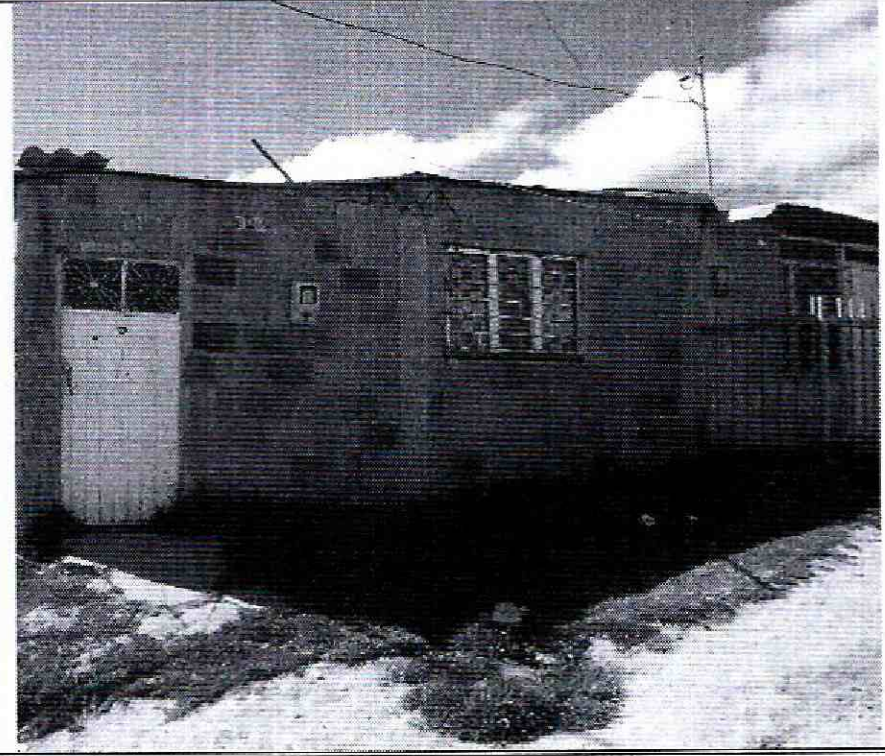
Foto No. 2. Aspecto de la vivienda emplazada en Calle 93 Sur No. 18B-06, en el Barrio Barranquitos-Mochuelo Bajo de la Localidad de Ciudad Bolívar
