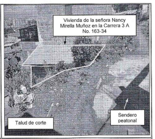
Fotografía 2. Parte alta del talud de corte implementado al parecer para el emplazamiento de la vivienda de la señora Nancy Mirella Muñoz, al costado oriental del predio de la Carrera 3 A No. 163 – 34 en el barrio Santa Cecilia Norte Parte Alta de la Localidad Usaquén. Se observa un acceso peatonal sin sistemas para el manejo de aguas de escorrentía superficial.
